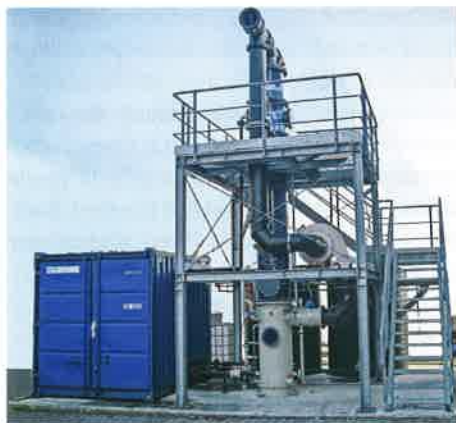
In der Envimac-Testanlage in Oberhausen wurden die Vergleichsmessungen durchgeführt
