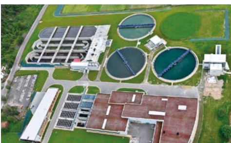
Kläranlage zur biologischen Abwasserreinigung
