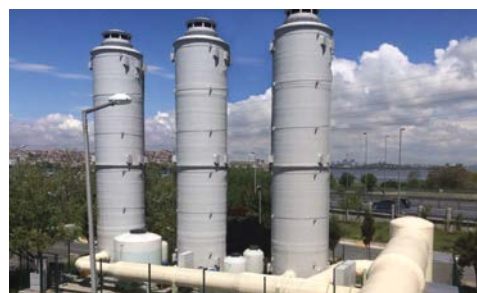
Biotricklingfilter entfernen Gerüche von der Kläranlage
