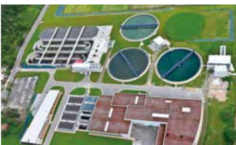
Kläranlage zur biologischen Abwasserreinigung
