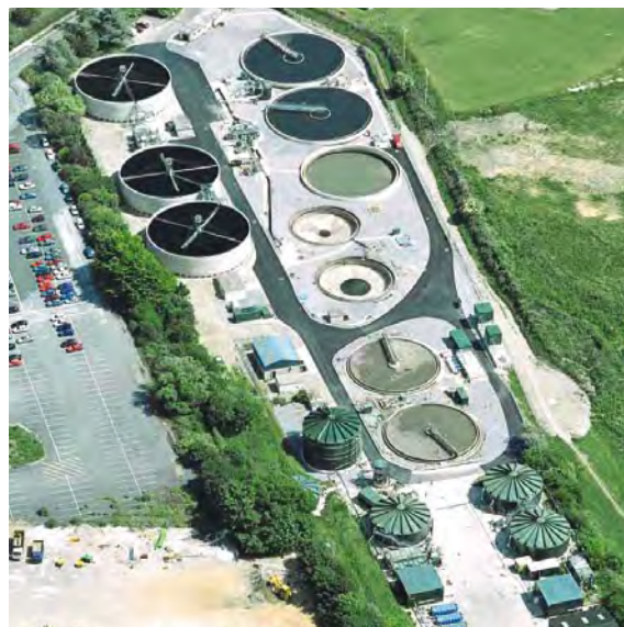
2H BIOdek® Kommunale Abwasseranlage Ernesettle, Großbritannien
