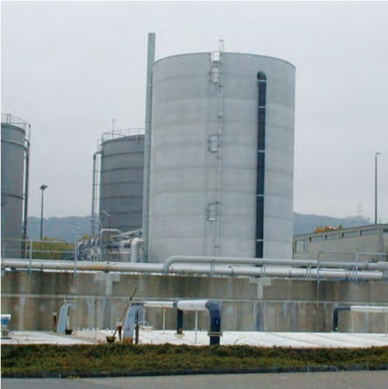
2+ BIOdek® Industrietropfkörper mit 16 m Füllhöhe Region Basel, Schweiz
