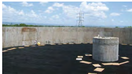
2H BIOdek® Managua: 6 Tropfkörper mit insgesamt 30.000 m 3 Volumen für 1,5 Mio. Einwohner (2007 in der Bauphase).
