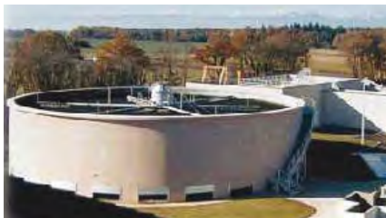
2H BIOdek® Nitrifizierender Tropfkörper am Genfer See in konzentrischer Anordnung zweier Stufen. Ablauf < 1 mg/l Ammonium.
