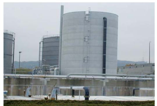
Industrietropfkörper mit 16 m Füllhöhe in der Region Basel, Schweiz
