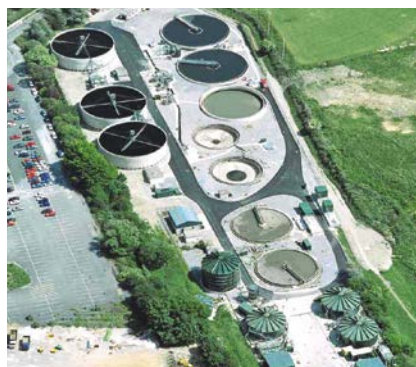
Kommunale Abwasseranlage in Ernesettle, Großbritannien
