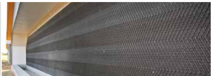
Abluftreinigung mit 2H NET 150
